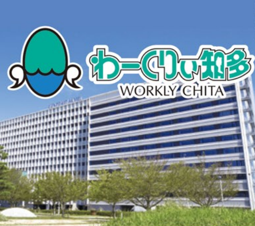
中部国際空港セントレアホテル
